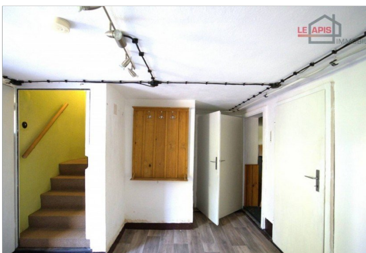
Kellerbereich m. Treppenzugang v. Haus
