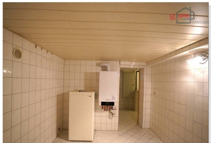
Raum 2 Bild 2 Keller
