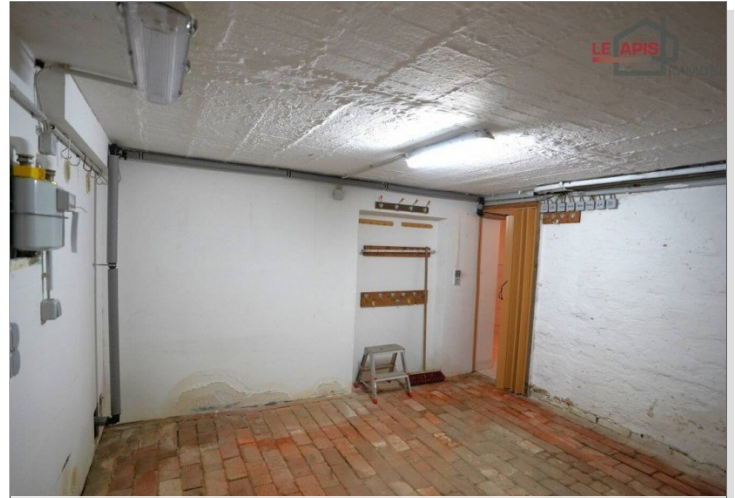
Raum 1 Bild 2 Keller
