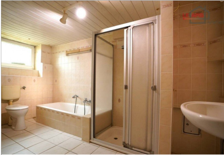
Tageslichtbad im Kellerbereich
