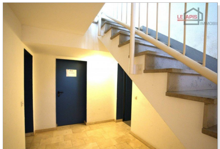
Treppenhaus Zugang zum Kellerbereich
