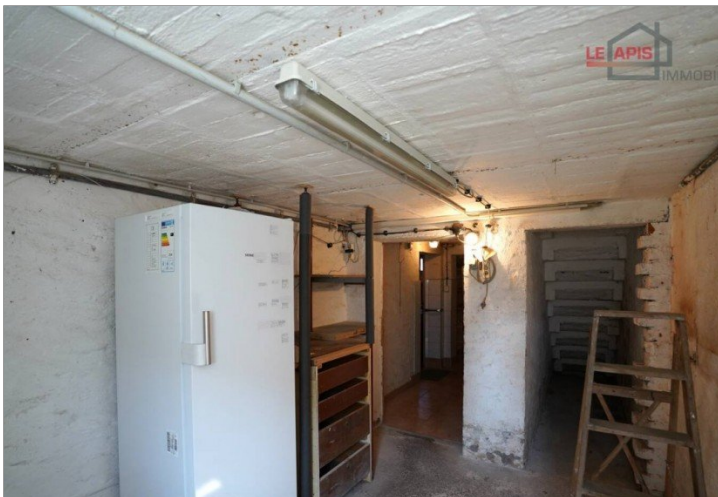
Abstellraum Keller Bild 2
