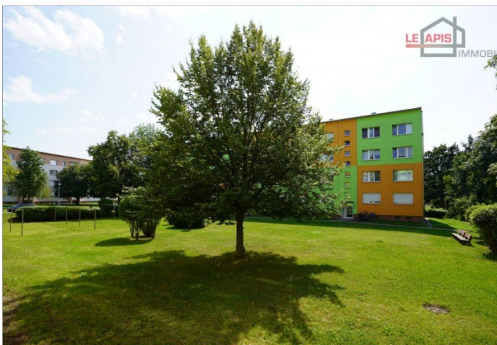
Gartenbereich u. Wäscheplatz
