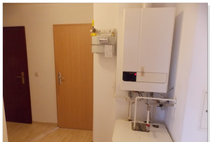
Gasetagenheizung
