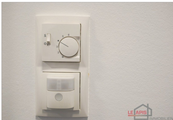
Regelung Fußbodenheizung u. Bewegungsmelder im Flur
