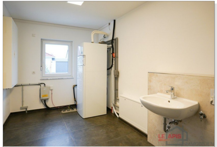
Hauswirtschaftsraum inkl. Heizungsanlage
