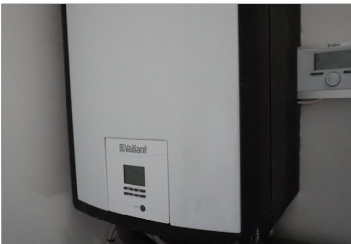
Lüft-/ Wärmepumpe Heizung
