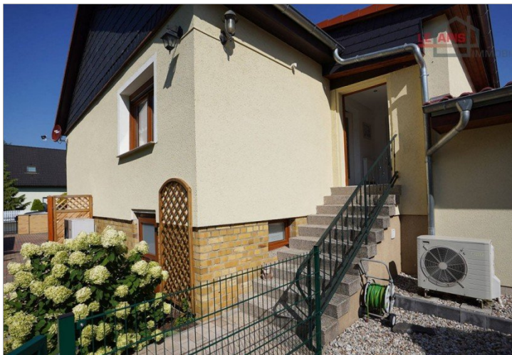
Treppenaufgang zum Hauseingangsbereich
